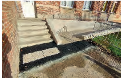
La rampe PMR à l'école Saint-Exupéry
